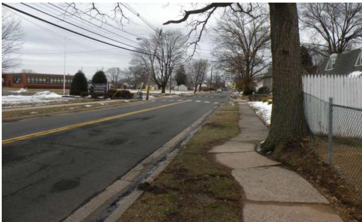
Sidewalk upheaval caused by tree roots on Brooks Blvd between N.11 th & N.10 th
